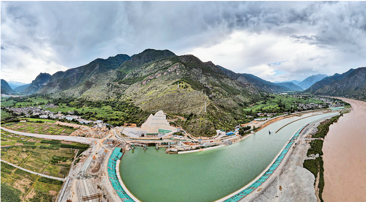
连日来,滇中引水两大主体工程之一的石鼓水源工程进水塔边坡,建设者正在紧张施工,稳步推进工程进度。石鼓水源工程含大小平洞、竖井共95条,目前完成隧洞开挖46条,累计长度18.4公里,约占该项目总长的81.5%。 本报记者 黄兴能 摄
