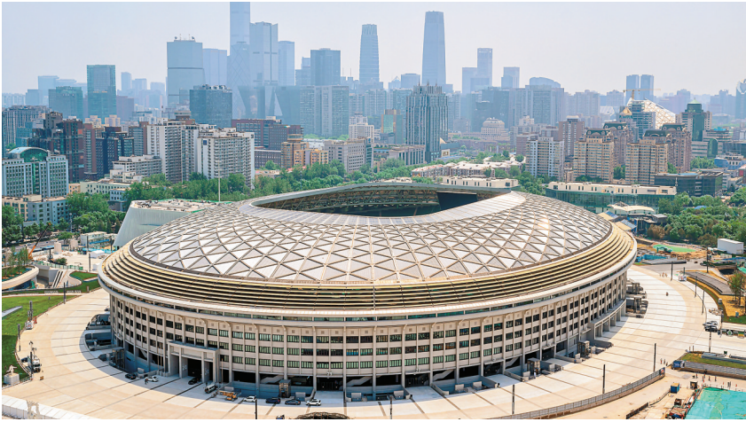
改建后的北京工人体育场，屋顶金色外圈为隆基绿能BIPV产品，装机总量351千瓦，25年减碳量高达4930吨。
