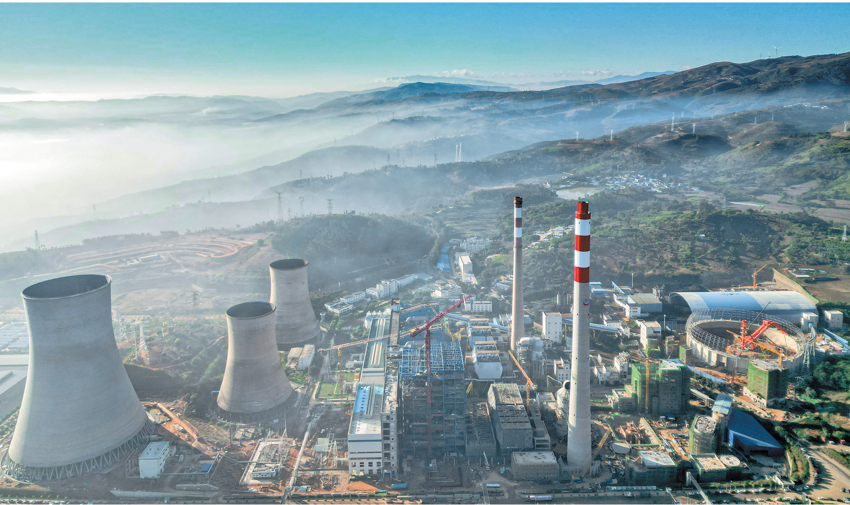
云南能投集团红河电厂二期项目。
