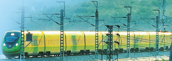
中老铁路外部供电项目。
