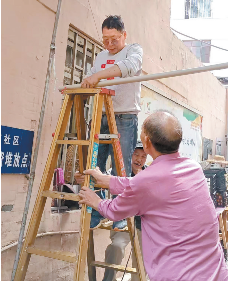
李长生和院坝居民梳理楼院电线。
