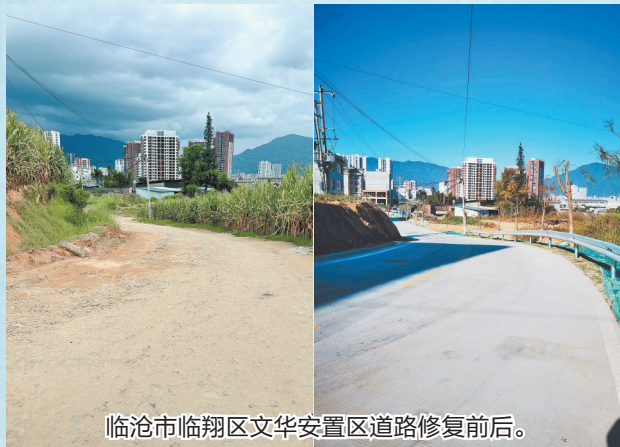
临沧市临翔区文华安置区道路修复前后。
