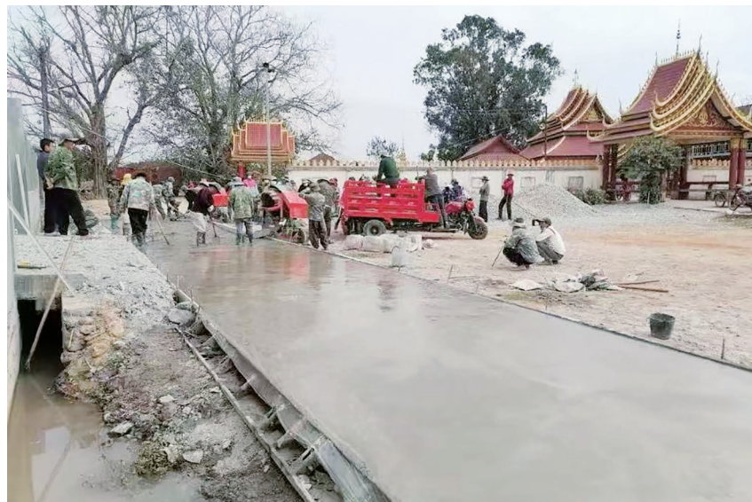
曼纳坎村修建水泥路。 供图
