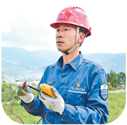
李建强在查看电力设备运行情况。 本报通讯员 龙振江 摄
