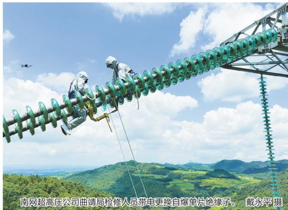
南网超高压公司曲靖局检修人员带电更换自爆单片绝缘子。 戴永平 摄
