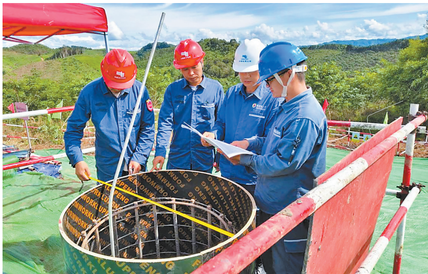
中老 500 千伏跨境联网工程(老挝段)首基铁塔基础浇筑仪式现场。 本报通讯员 徐苔林 供图
