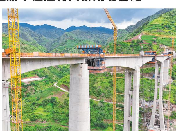
合龙精度控制在毫米级以内等挑战,保障了作业安全和工程质量,为高原峡谷地区大跨度连续梁施工积累了宝贵经验。 图为江底牛栏江特大桥。 本报通讯员 邓小龙 摄
