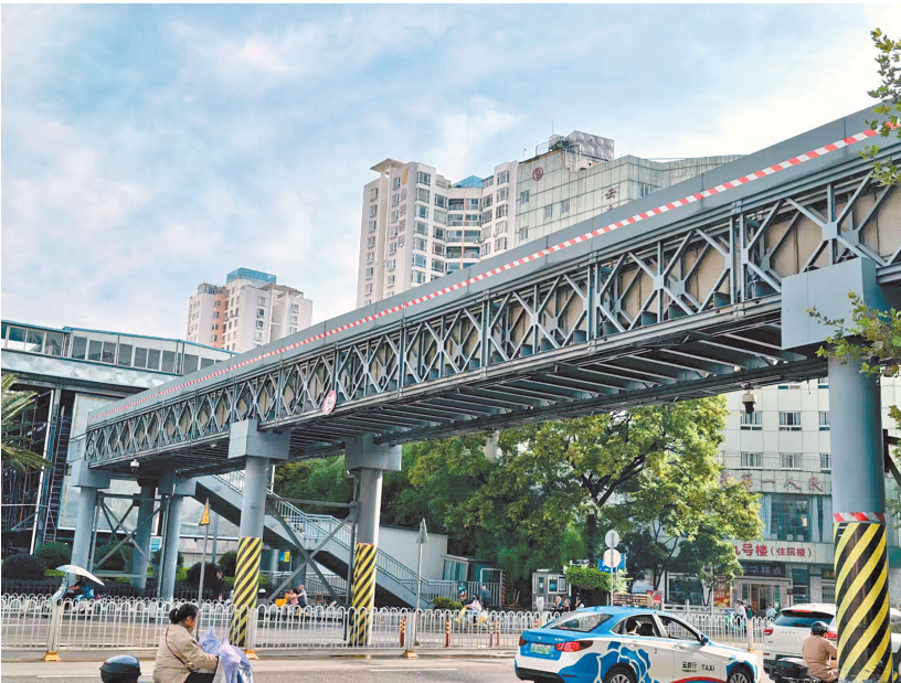
位于云南省第一人民医院门口的人行天桥。
