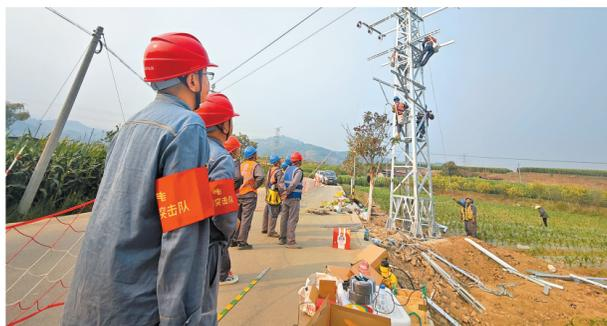
组织开展铁塔组立及配电网自动化设备安装。雷锦涛 摄
