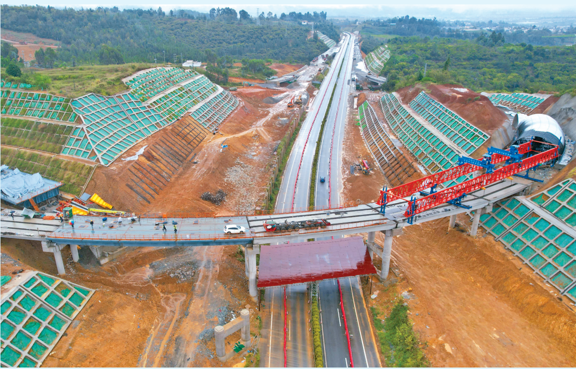
大保高速公路老营至板桥段改线工程施工现场。
