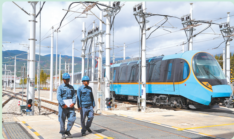
丽江供电局供电人员为雪山轻轨小火车开展用电服务。
