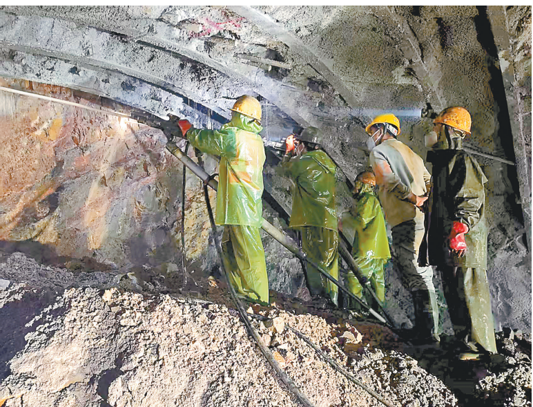
工人在梁王山隧道加紧施工。
