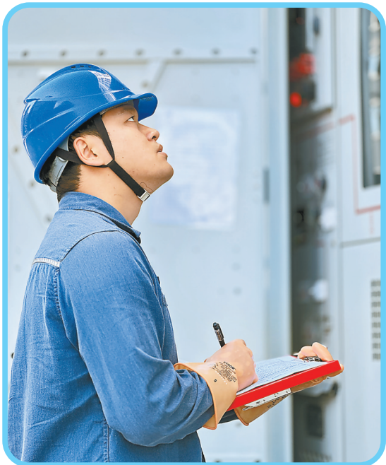
技术人员核对光伏并网设备参数,确保设备安全稳定运行。
