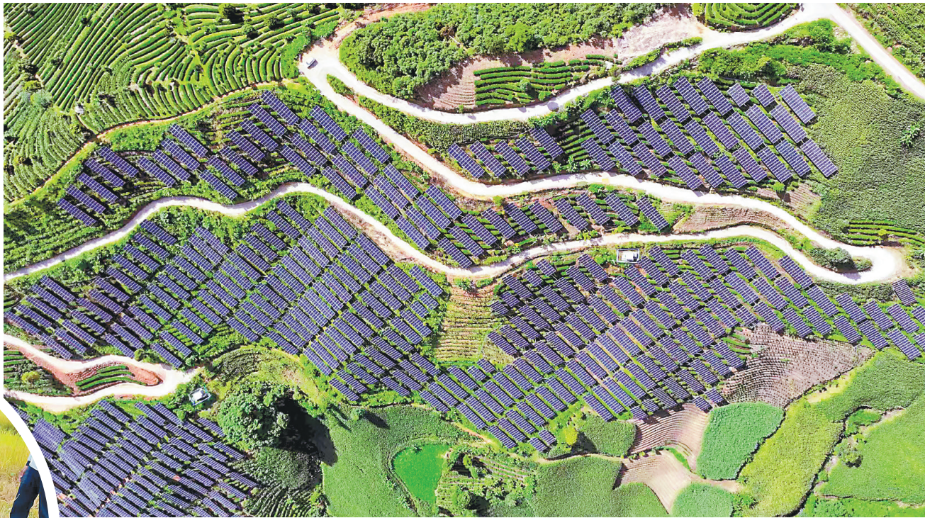
孟连县哈尼、允山复合光伏发电项目一角。 本报通讯员 唐小松 摄
