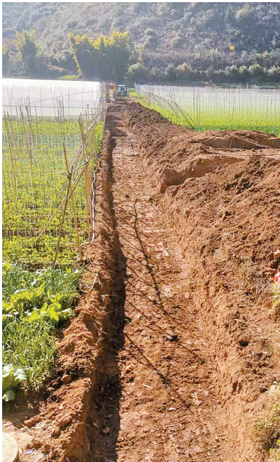
乐太村灌溉渠田间段土方开挖。
