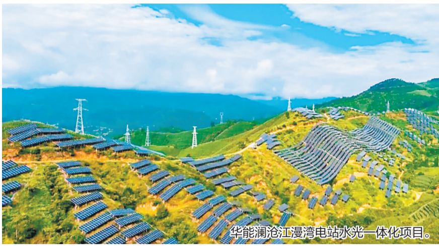
华能澜沧江漫湾电站水光一体化项目。
