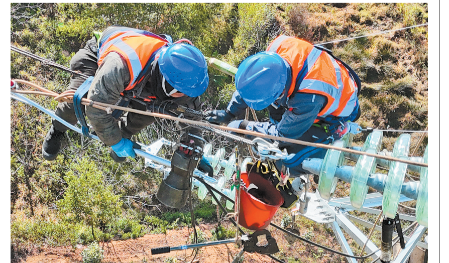
供电人员正在压接新建35千伏线路导线。 李兵宽 摄
