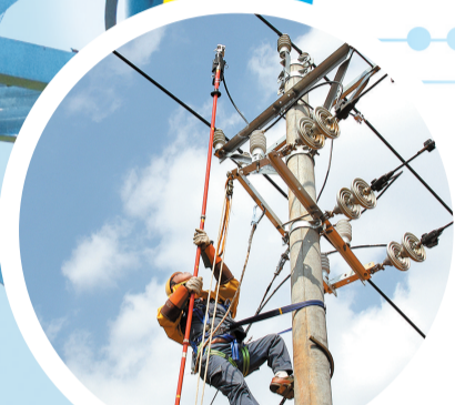
工作人员使用电动射枪式绝缘操作杆开展带电搭火工作。高春燕 摄
