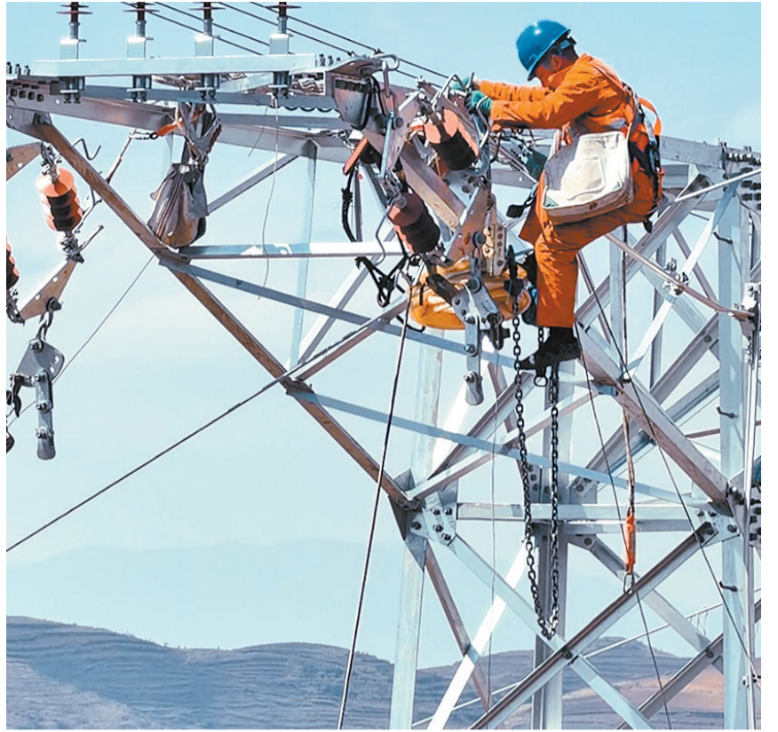
渝昆高铁八仙营牵引变220千伏外部供电工程。 吴学迁 摄
