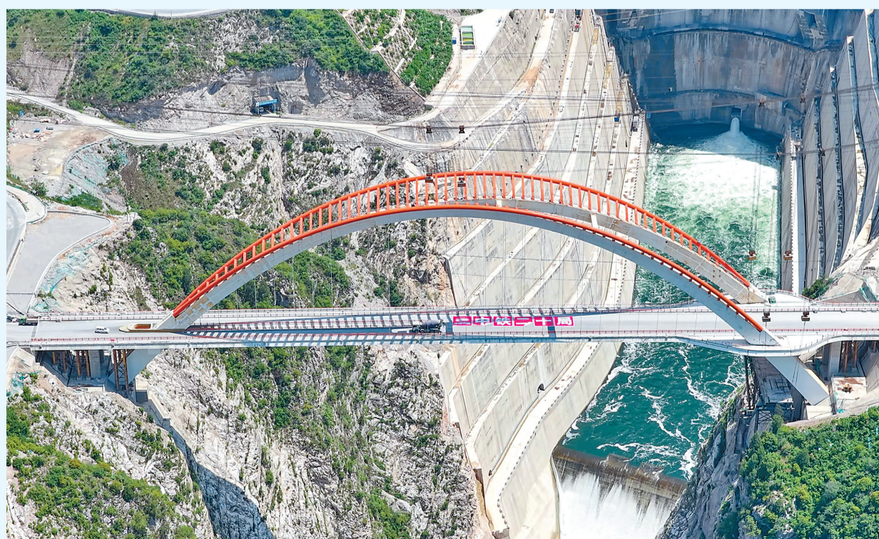
5月21日，由中铁二十局承建的陕西东庄水利枢纽泾河大桥完工。泾河大桥全长284米，是国内首例中承式空间Y型钢箱拱桥。东庄水利枢纽是国家重大水利工程，泾河大桥的建成不仅能保障东庄水利枢纽的建设，也能改善区域交通条件。图为5月21日拍摄的陕西东庄水利枢纽泾河大桥。
