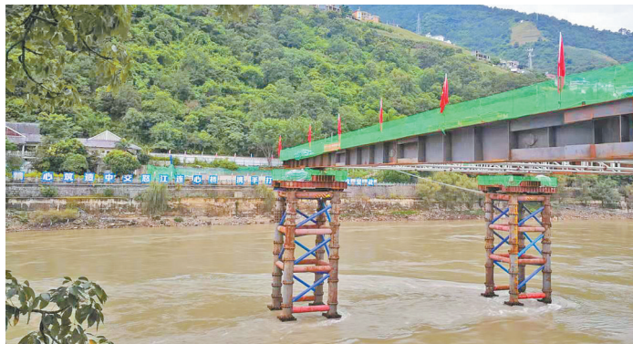
正在建设的怒江中交连心桥
