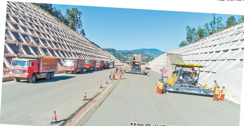
楚姚毫米级高精度“3D摊铺”现场
