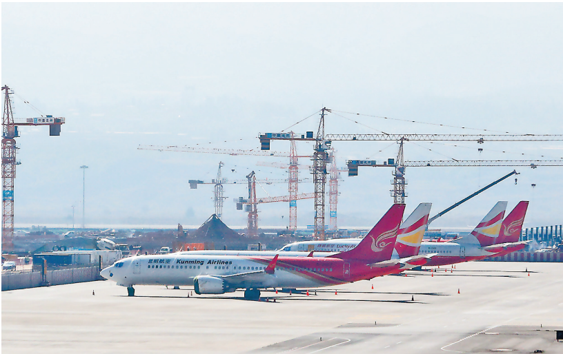
昆明长水国际机场改扩建工程。
