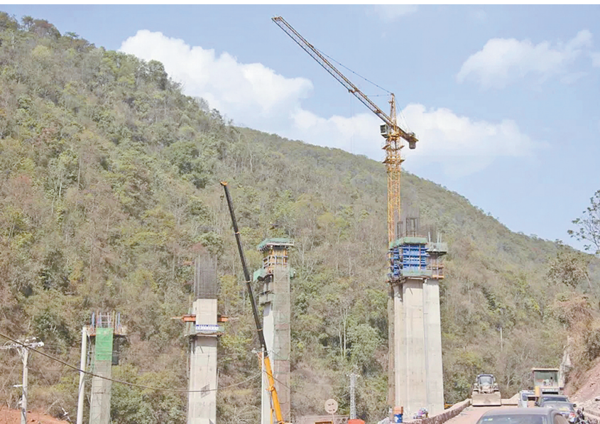
高速公路复工
