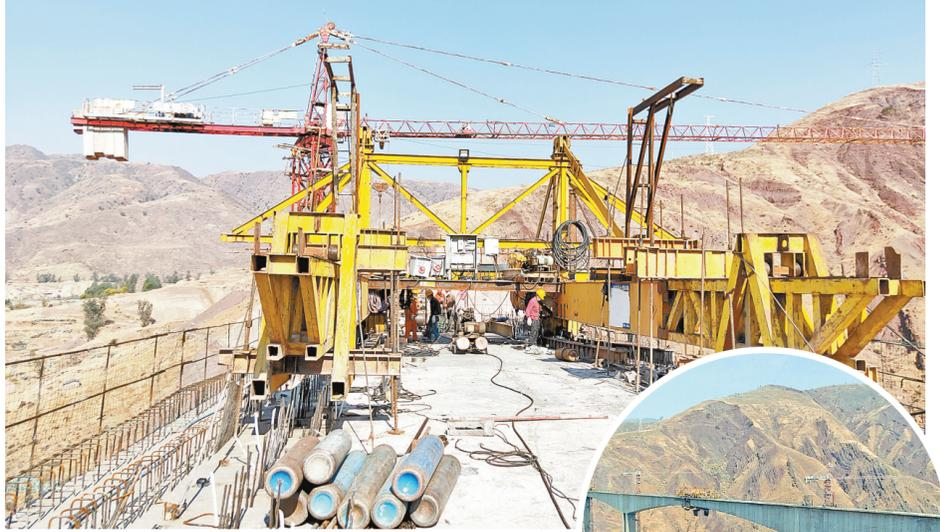
连日来,元谋县金沙江畔电机轰鸣,飞跃江面的龙街大桥工地一片忙碌,10多名工人正在距离地面80多米的桥梁上进行主桥预应力施工。
