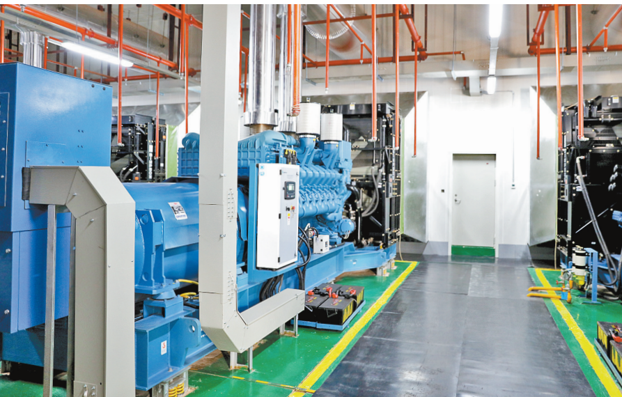
防断电应急发电机组
