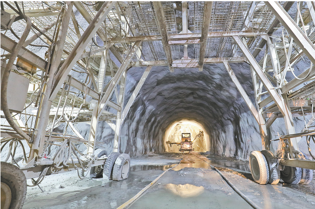
隧道建设现场
