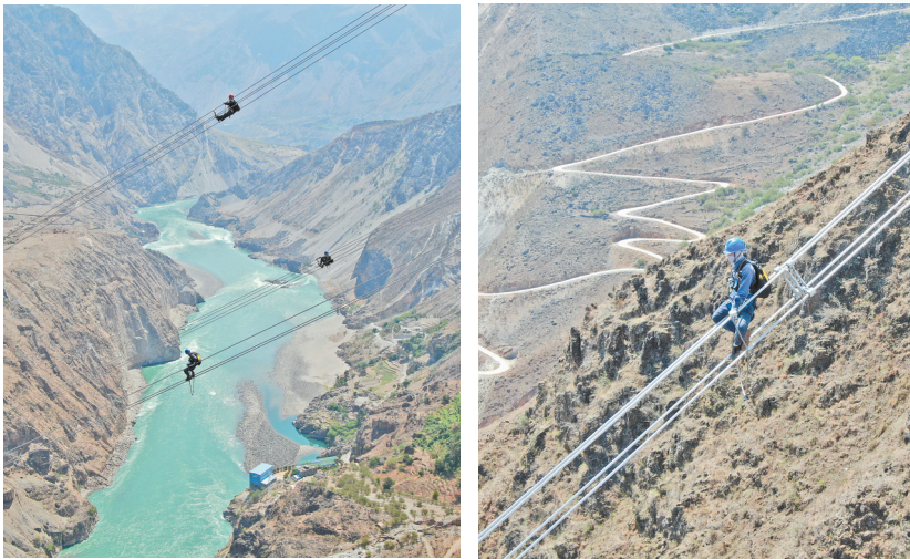
500千伏乌劝甲线跨江跨省段走线验收
