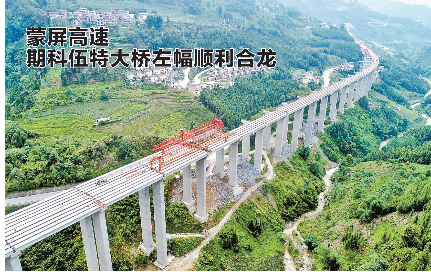
随着最后一块T梁顺利吊装完成,由云南建投集团投资建设的蒙自至屏边高速公路上唯一一座特大桥——期科伍特大桥左幅近日顺利合龙。蒙屏高速起自蒙自市冷泉镇,止于屏边苗族自治县滴水苗城寨门,全长40.437公里,采用4车道高速公路标准建设,设计时速80公里,项目概算总投资65.42亿元。全线有13座隧道、35座桥梁,桥隧比高达68.8%,沿线山高坡陡,生态环境脆弱、水文环境复杂,基本涵盖山区高速公路建设的全部重点难点。项目于2017年12月6日正式开工,计划2020年11月30日建成通车。
