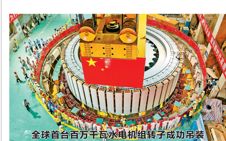
全球首台百万千瓦水轮发电机组转子成功吊装
