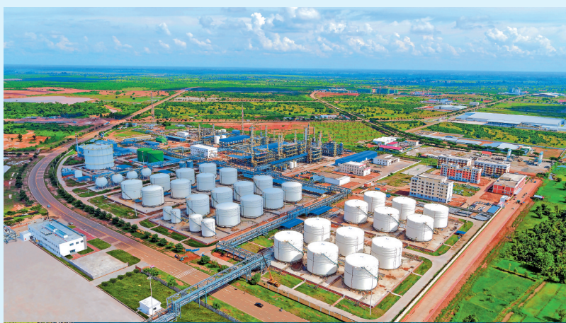
老挝石油化工有限公司年产300万吨炼化项目一期
