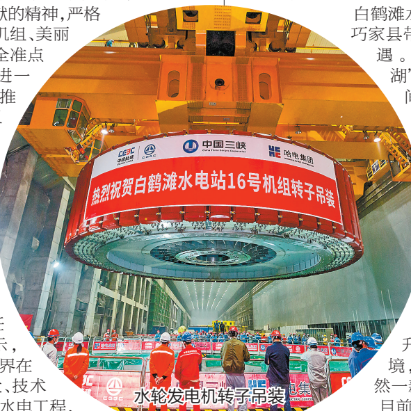
水轮发电机转子吊装 通讯员 卢忠灿 摄
