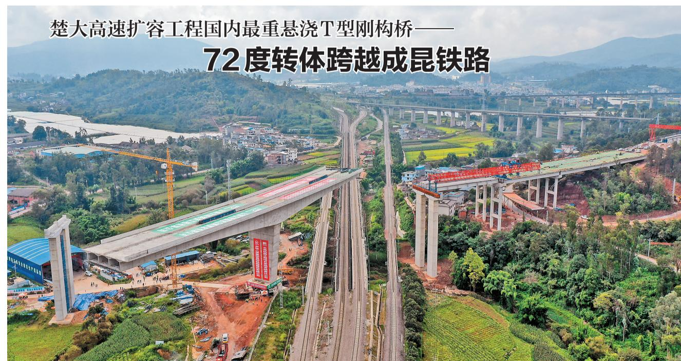
本报讯(记者 胡晓蓉) 9月10日上午，楚(雄)大(理)高速公路扩容工程——广通枢纽连接线上跨成昆铁路立交桥，采用转体法施工，重达2.36万吨
