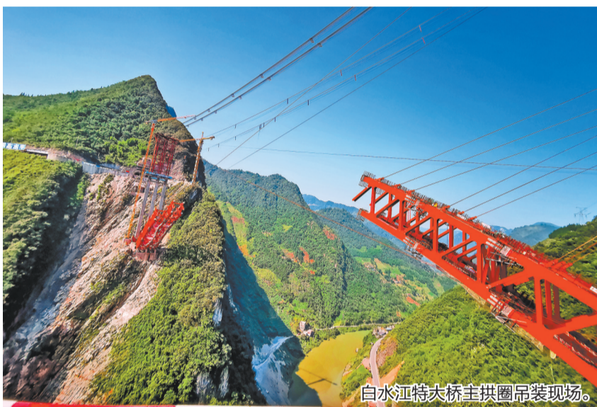
白水江特大桥主拱圈吊装现场。
