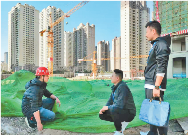
五华区纪委监委全面推动烂尾楼专项整治监督检查工作，切实为群众办实事。图为工作人员到工地实地了解复工复产推进情况。
