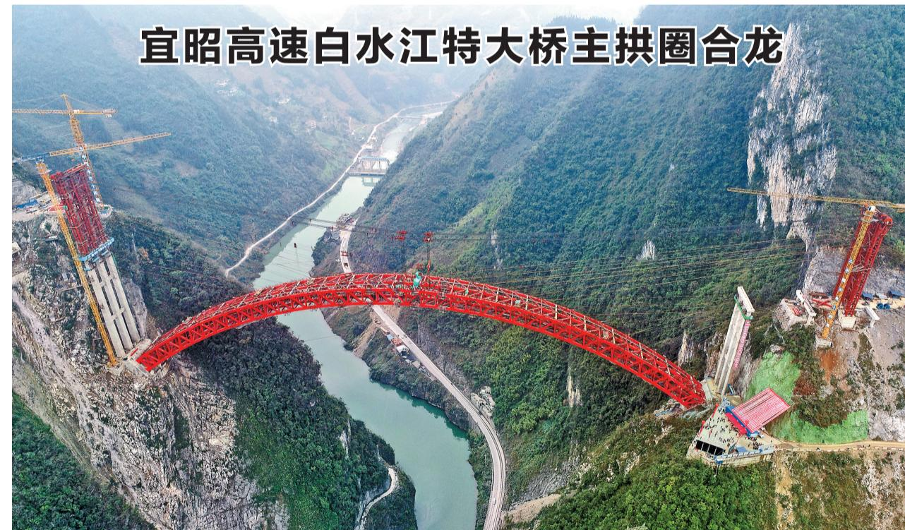
本报讯（记者 谢毅）12月14日15时，随着最后一节拱肋吊装完成，目前国内在建最大跨径和施工难度最大的拱桥——宜（四川宜宾）昭（云南昭通）高速公路白水江特大桥主拱圈在333米的高空成功合龙。主拱圈的顺利合龙，标志着白水江特大桥核心部分已经施工完成，宜昭高速公路二期建设项目建设取得重大突破性进展。
