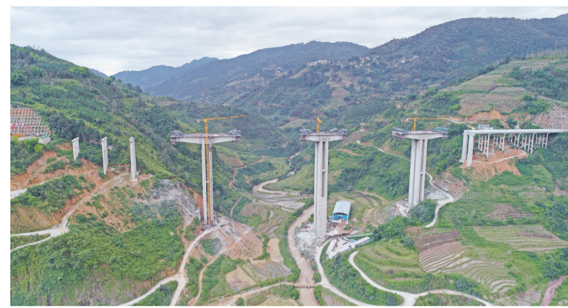
白那河特大桥
