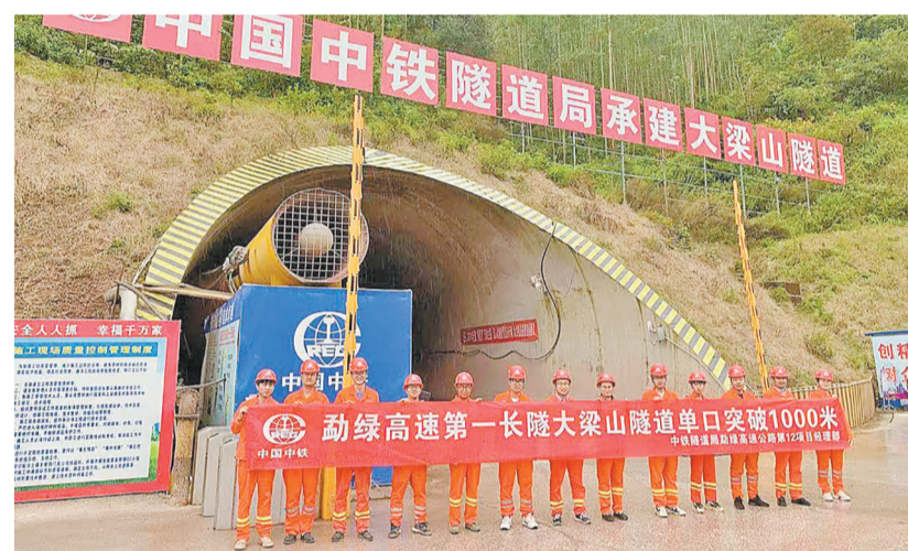
大梁山隧道入口
