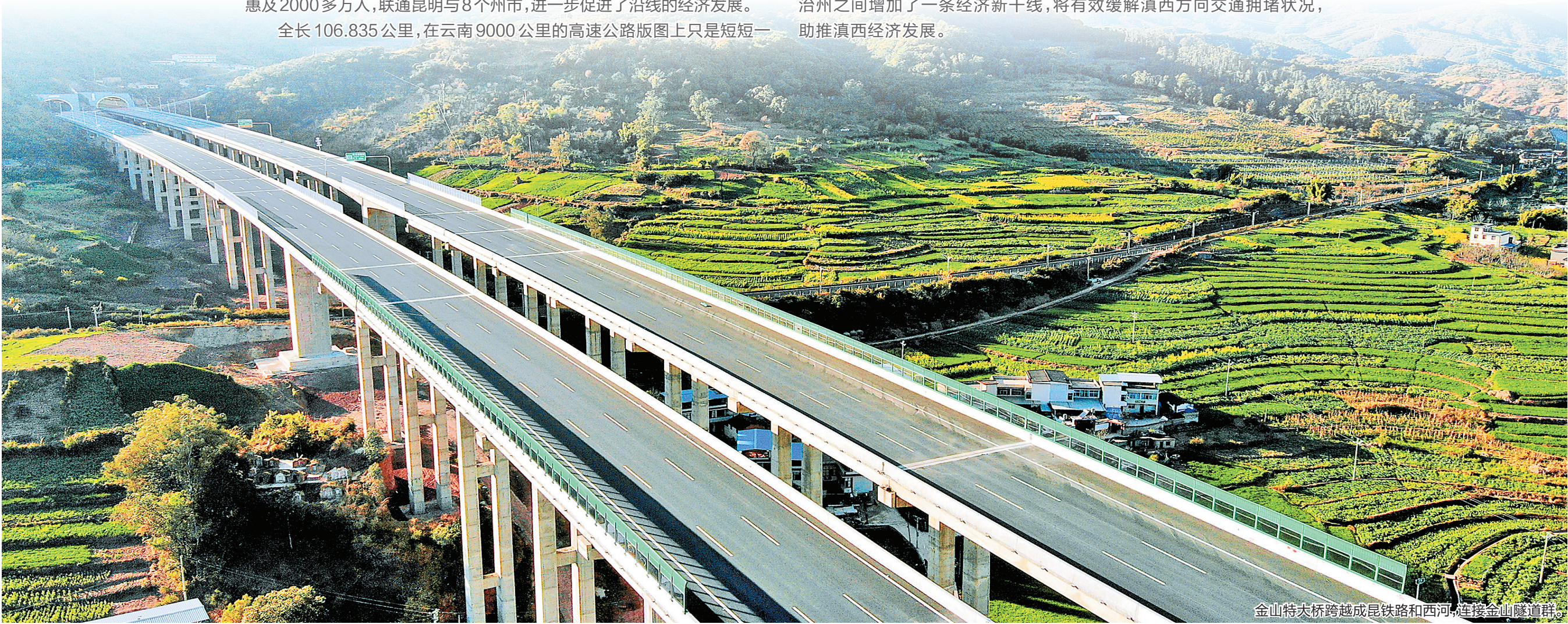
金山特大桥跨越成昆铁路和西河,连接金山隧道群。
