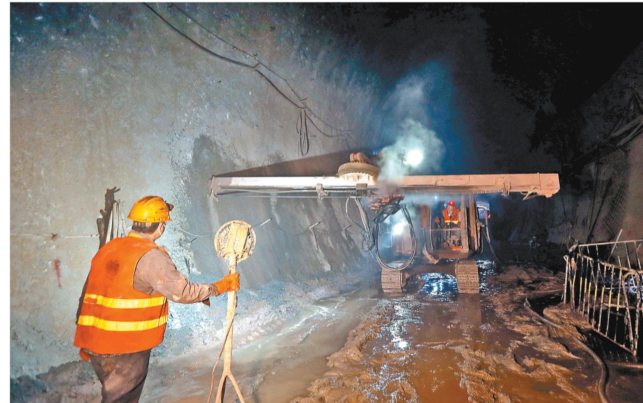
连日来，中国水电七局滇中引水工程大理Ⅱ段施工4标项目隧道中机器轰鸣、焊花飞舞，工人们正加紧施工。该项目自开工以来进展顺利，目前已完成比例过半。沿线共布置8个建筑物，隧道总长19.8公里，于2019年3月开工，计划2026年4月30日竣工。目前，已完成隧道开挖8788米(不含支洞)、隧道全断面衬砌6200.7米、暗涵全断面混凝土浇筑1440米。
