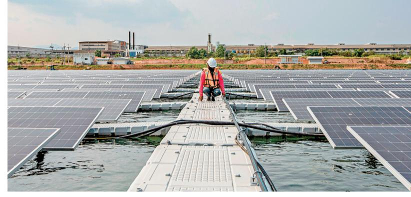
位于泰国罗勇府的水上漂浮式光伏电站由泰国万浦公司设计建设,中国华公司提供光伏逆变器及智能数据采集器等重要设备及技术支持,计划今年内开始供电。图为4月11日,工作人员在泰国罗勇府的水上漂浮式光伏电站检查电缆。
