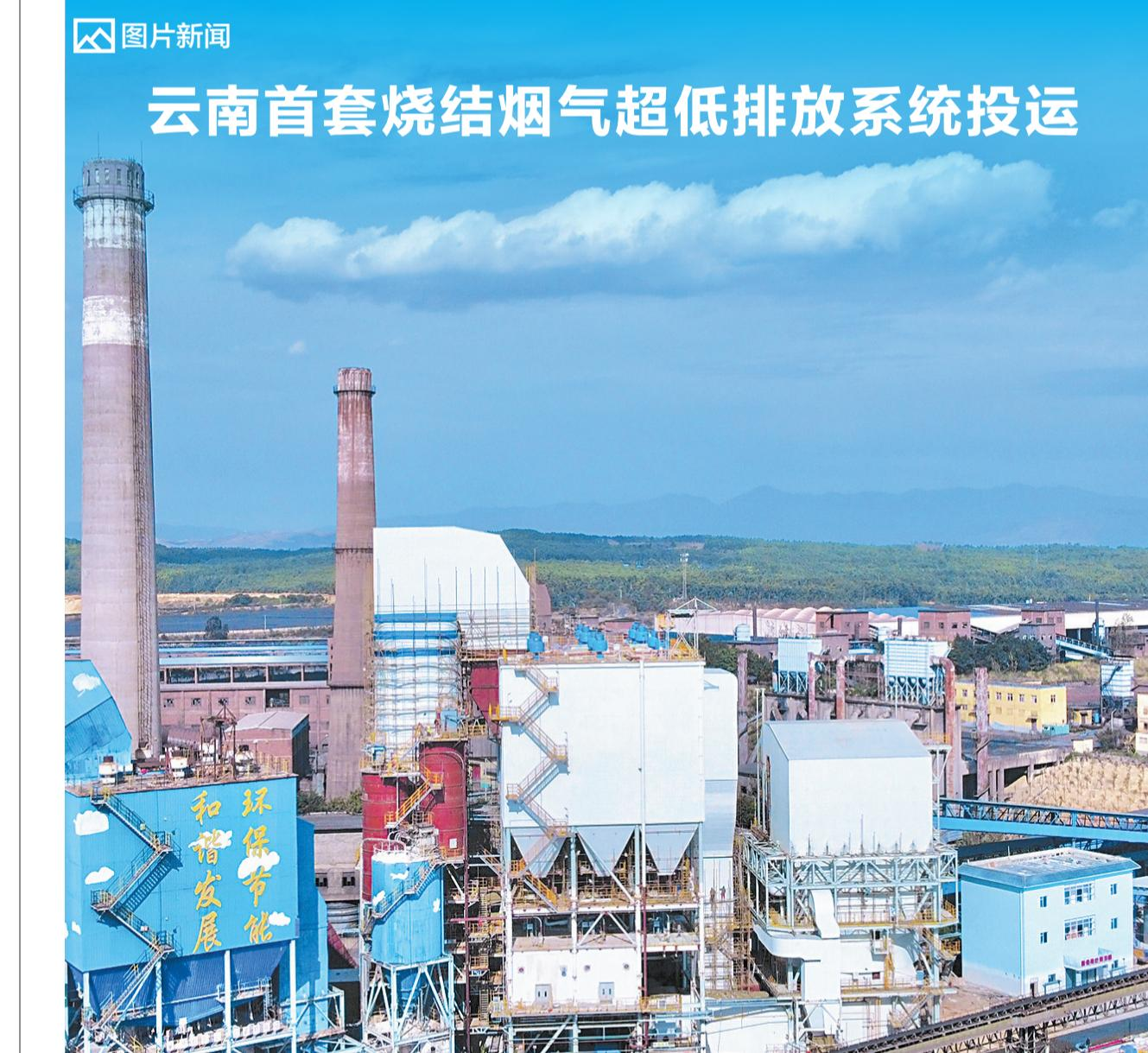
据了解,该项目是红钢公司充分利用现有装置及条件,采用循环流化床(CFB)半干法脱硫+SCR中高温脱硝技术对烧结机头烟气进行净化,在原有260平方米烧结机旁,新建一套全烟气脱硫脱硝装置,确保整个系统与烧结主机100%同步运行。
