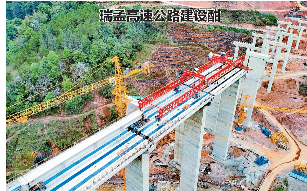
目前，瑞丽至孟连高速公路建设正酣，由云南交投集团云岭建设公司第四总包部承建的瑞孟高速公路102公里已完成路基开挖，桥梁桩基总任务的一半，隧道掘进完成近30%。瑞孟高速公路是我省“十三五”期间高速公路建设重点项目之一，路线涉及德宏、保山、临沧、普洱4个州市，全长512.11公里，按双向4车道标准建设，计划2024年通车。图为3号跨线桥正在吊装梁板。
