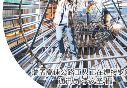
瑞孟高速公路工人正在焊接钢筋笼
