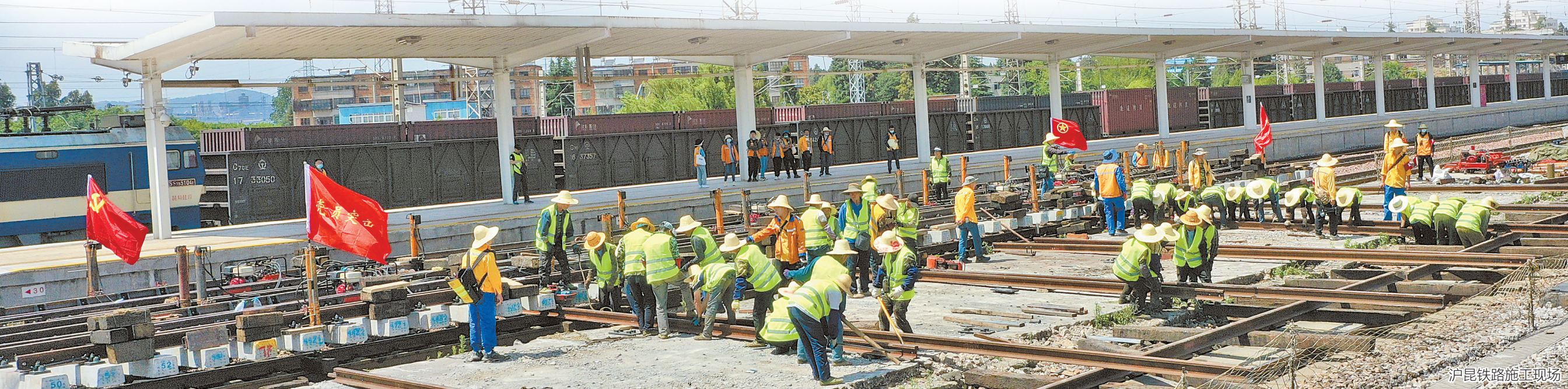
沪昆铁路施工现场
