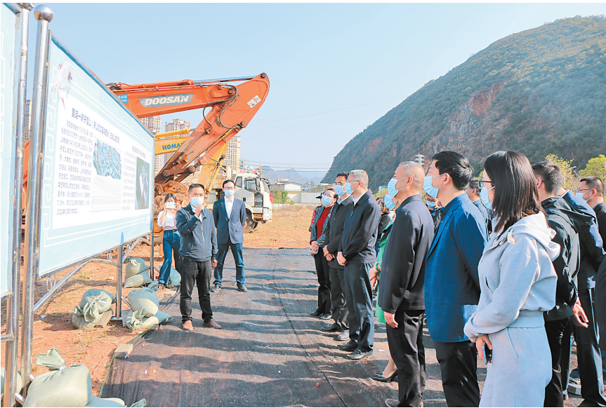
禄劝县重点项目建设现场
