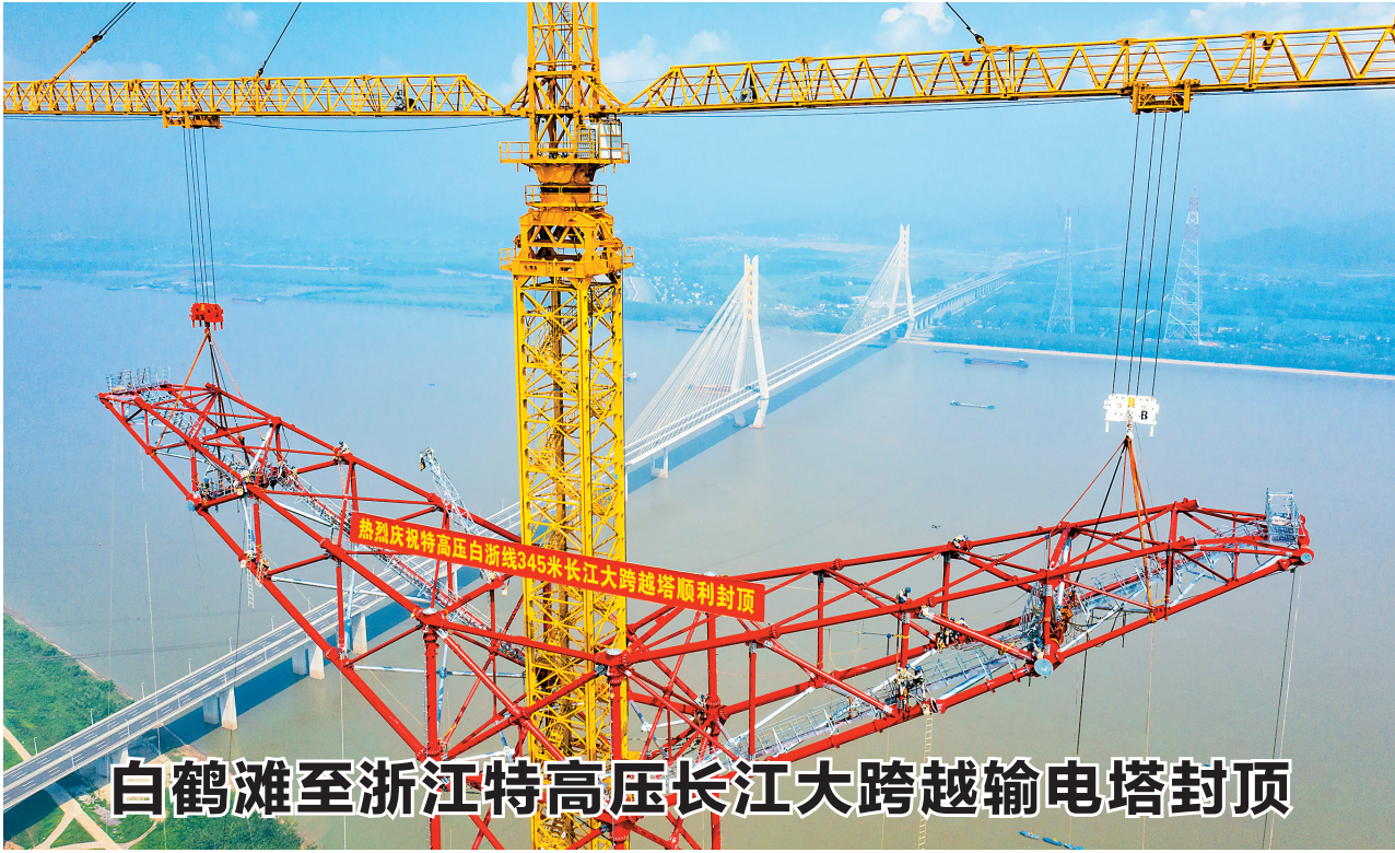
8月1日,经过建设者150余天的奋战,白鹤滩至浙江±800千伏特高压直流输电工程安徽池州长江大跨越高345米的南岸跨越塔成功封顶。白浙线是我国实施“西电东送”战略的重点工程,送端连接目前世界在建最大水电站白鹤滩水电站,受端位于杭州临平区宁波姚江站,线路全长2140.2公里。图为安徽送变电工程有限公司施工人员在池州长江大跨越南岸跨越塔封顶施工现场作业。 新华社发 郑贤列 摄
